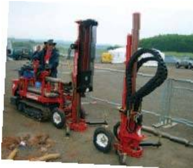
mini rig to set guard poles
